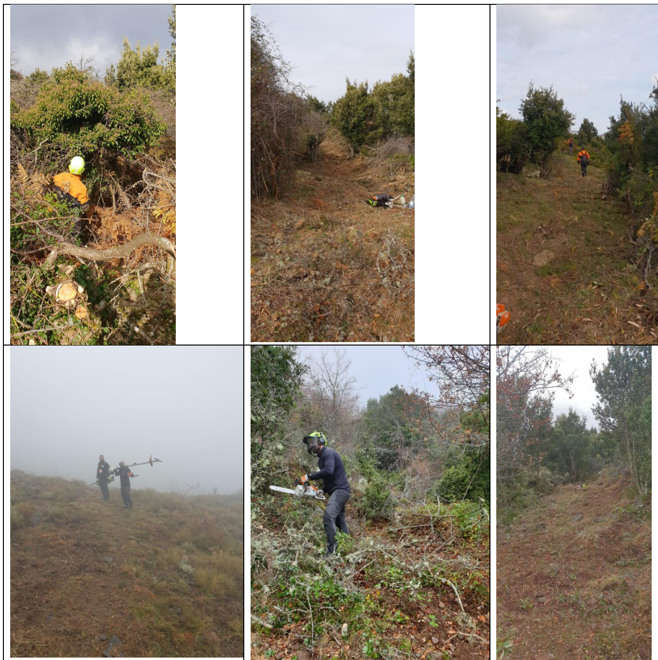
Chantier sentier Rusiu – Col de San Antone 7kms d'ouverture
