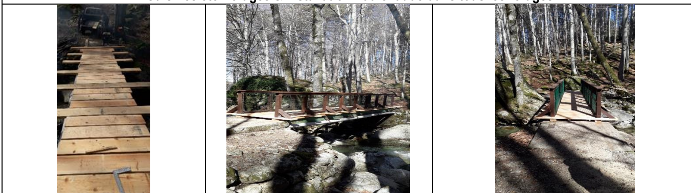
« Passerelle Fiuminaltu à Vizzavona – commune de Vivario »
