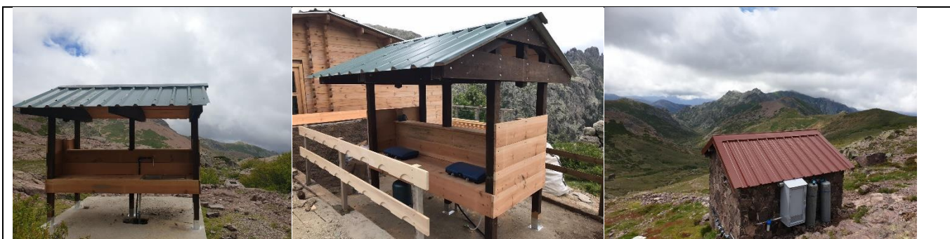
« Cuisines été Refuges & Installation Eau chaude dans tous les refuges »
